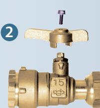
Dépose de la manette standard après desserrage de la vis
